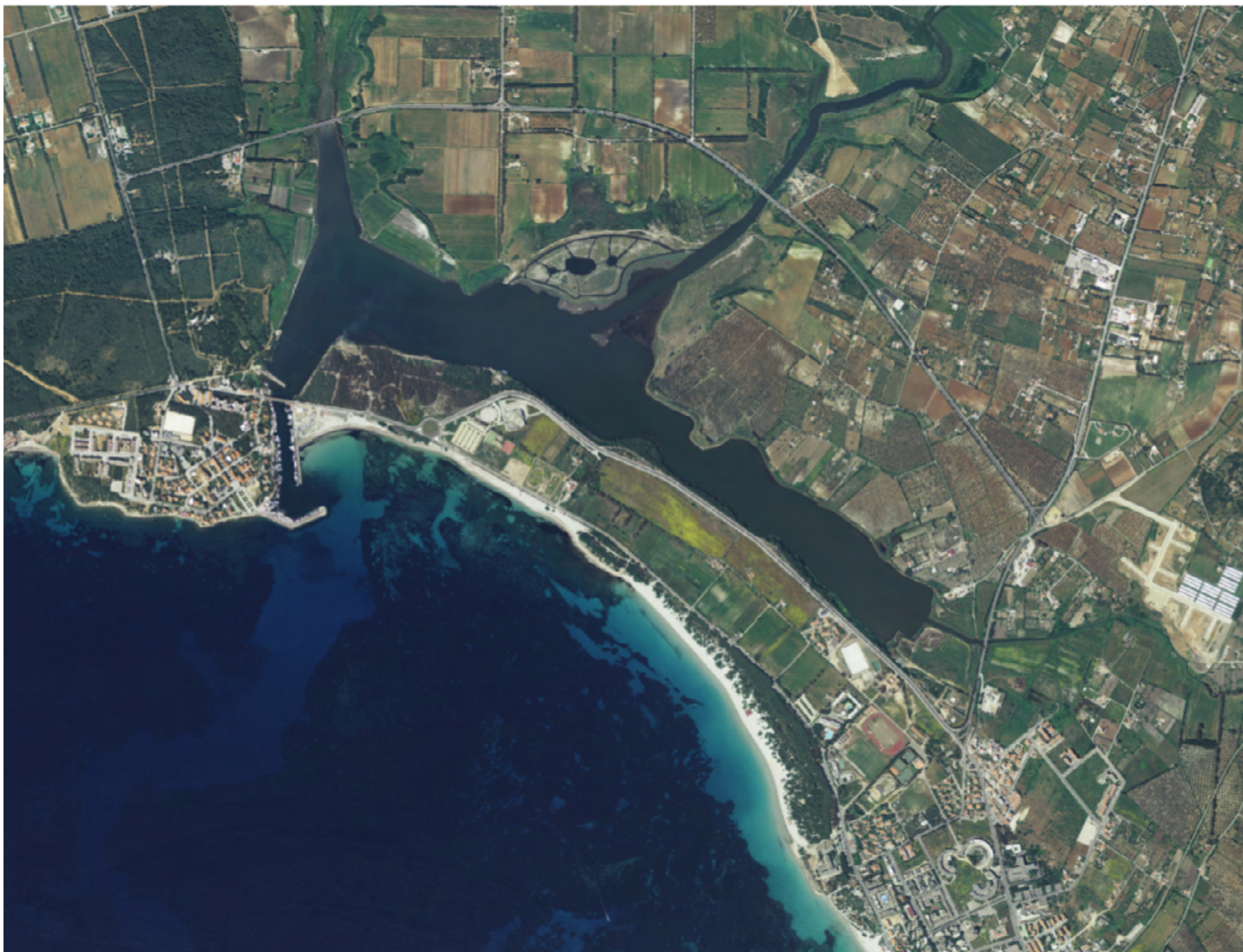
Figura 15 - Lo stato di fatto attuale - immagine di progetto realizzata per l'incontro partecipativo Mappe di Comunità
