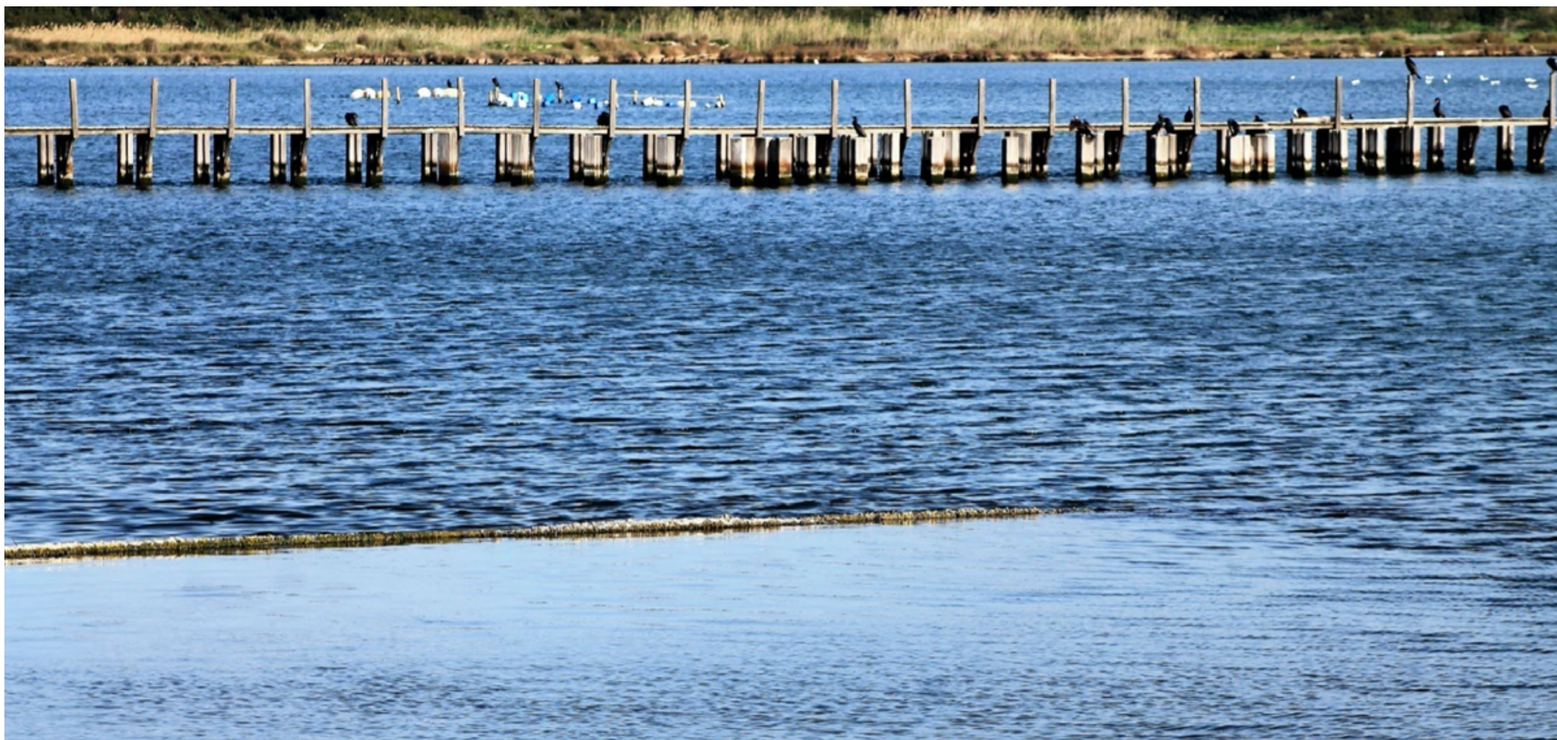
Figura 17 - Il lavoriero visto dal ponte Romanico e, in secondo piano, la stazione sperimentale di allevamento bivalvi.
